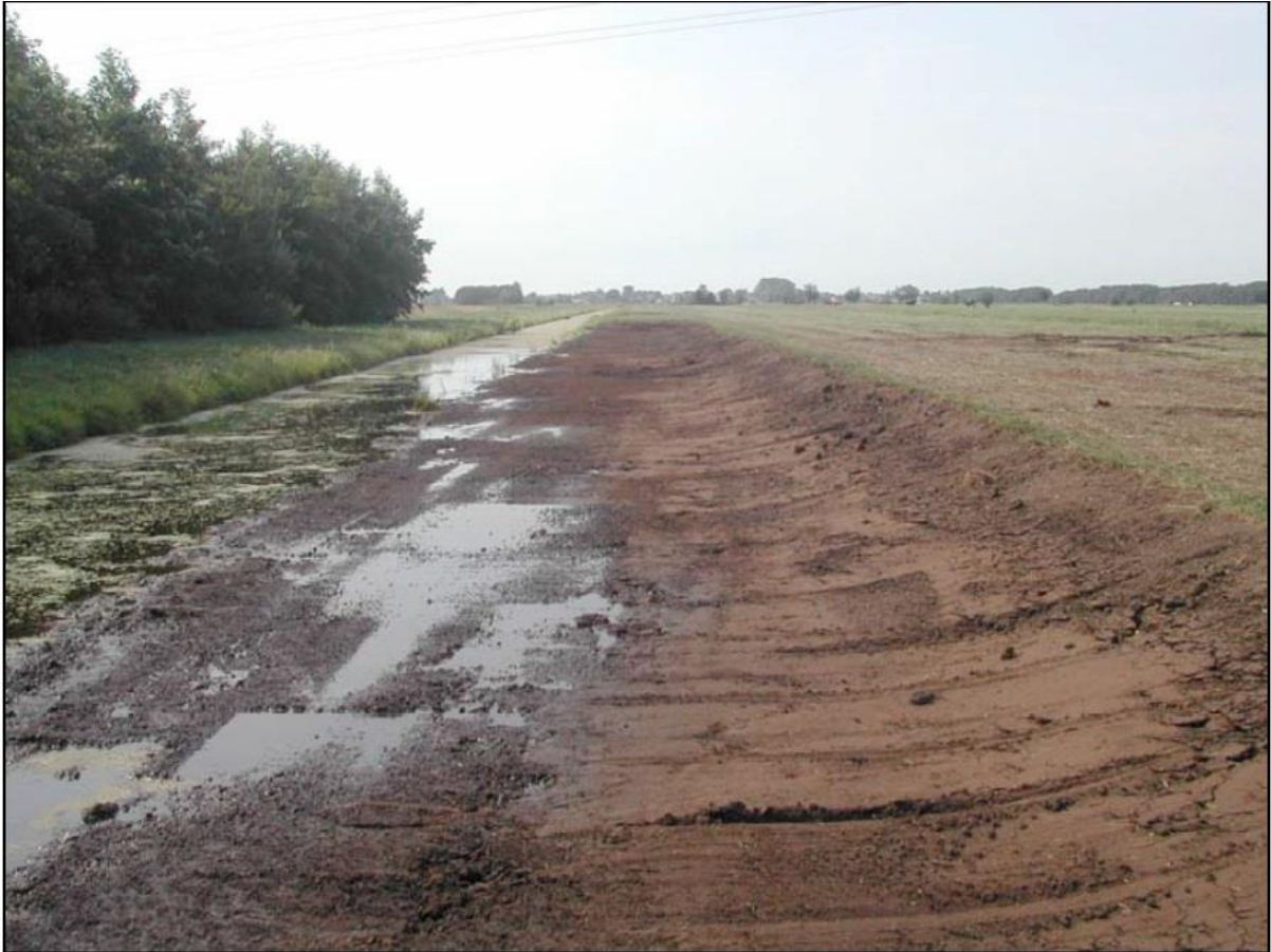
Figuur 2. Afvlakken van sloot/watergangtalud en gelijktijdig verbreden van sloot/watergang. (Foto R. Terlouw).
